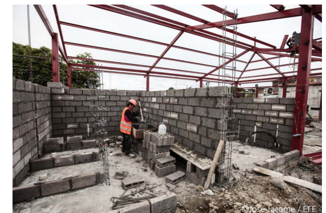
Reconstrucción de mercado en Pedernales tras terremoto
