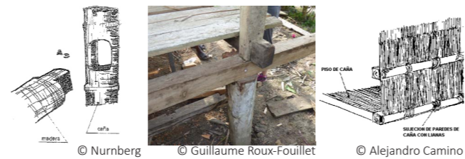
Izquierda: ensamble «boca de sapo» en caña guadua (bambú). Centro: detalle de unión estructura vertical y entrepiso de madera. Derecha: ensamblaje de paredes con liana.
