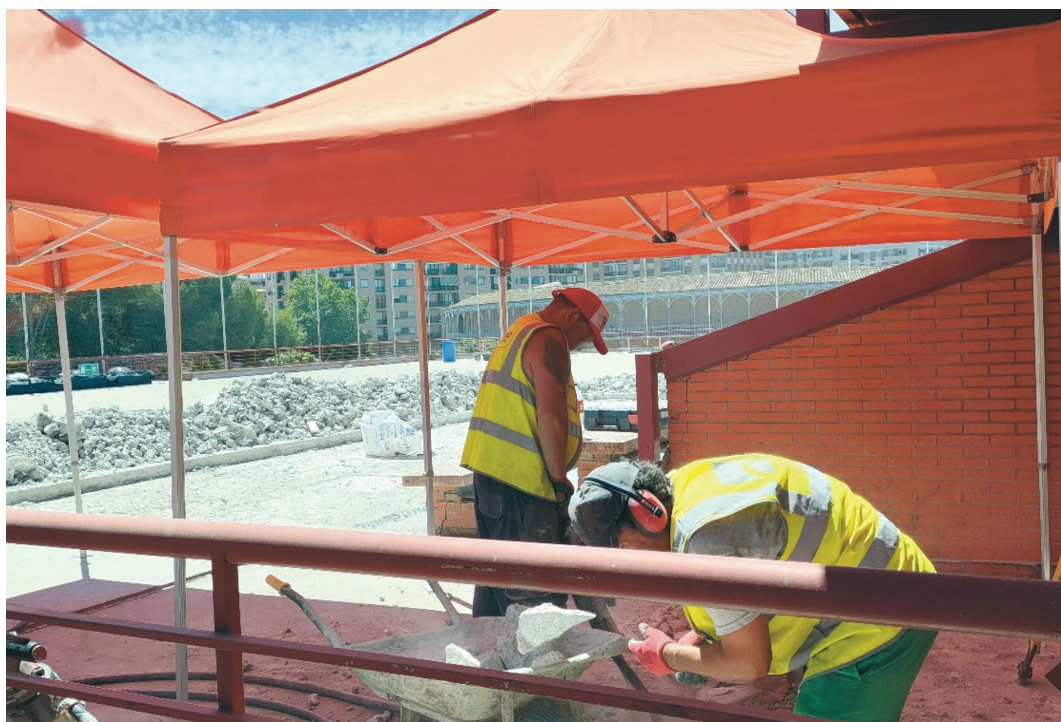
Imagen 4. Trabajos ejecutados en sombra.
