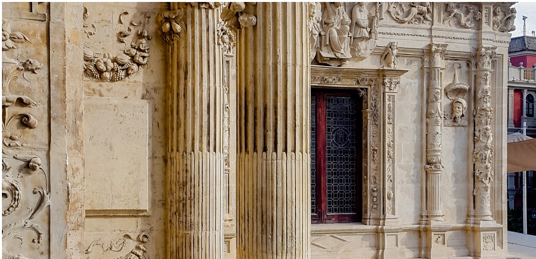
De izquierda a derecha, fachada Renacentista de la Casa Consistorial de Sevilla y a l fondo Edificio la Adriática
